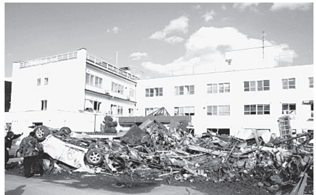
2階まで津波が押し寄せたが、患者を全員屋上に避難させ、患者も職員も一人の犠牲もださなかった県立大槌病院。病院前は瓦礫の山。(3月28日写す)
